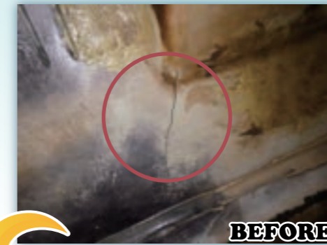
浄化槽内修理
