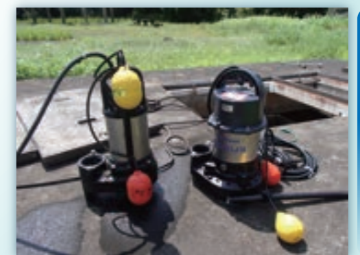
水中ポンプ交換
